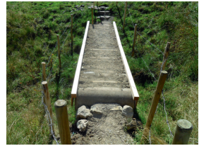
Der fertige Übergang
